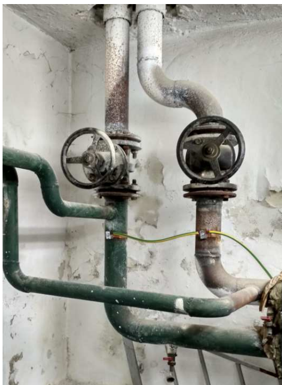
přípojka teplovodu do objektu A
